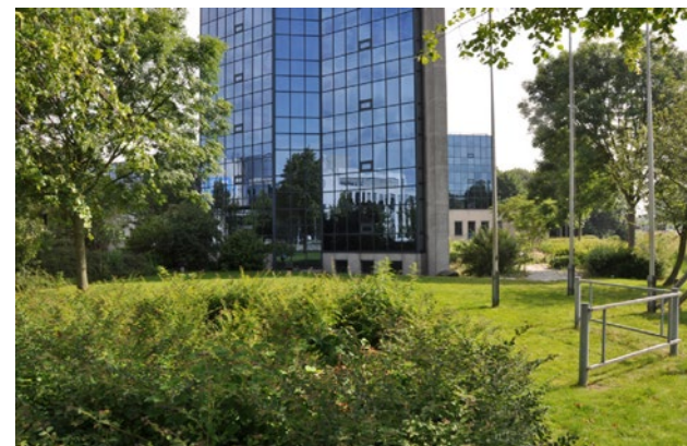
Afbeelding 11, Groene omzoming gebouwen langs Kanaalweg
