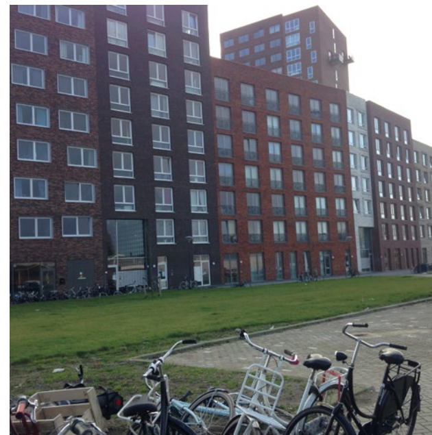
Afbeelding 12, Yours Leiden en openbare ruimte in aanbouw
