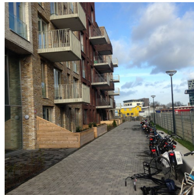
Afbeelding 13, Yours Leiden en openbare ruimte in aanbouw
