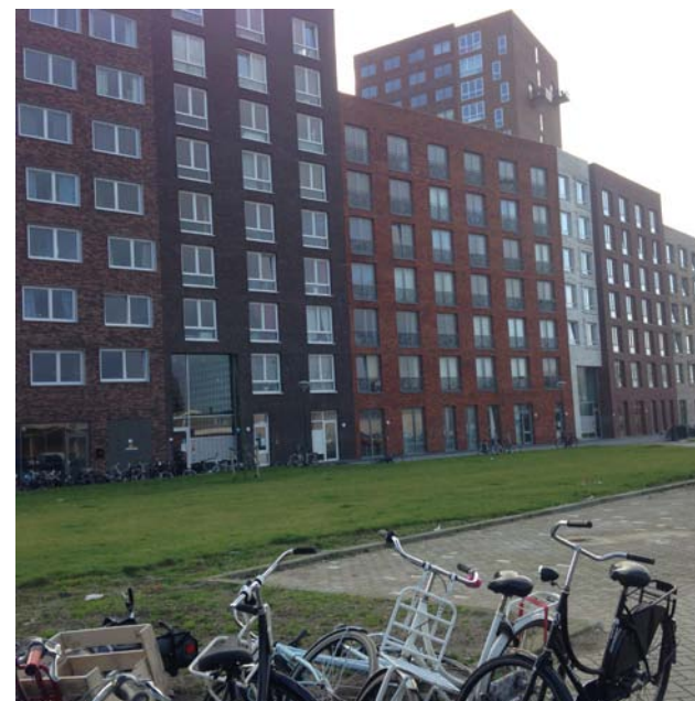
Afbeelding 13, De Leidse Schans en openbare ruimte in aanbouw
