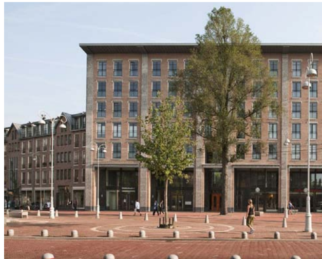
Referentiebeelden bebouwing langs de Lammenschansweg
