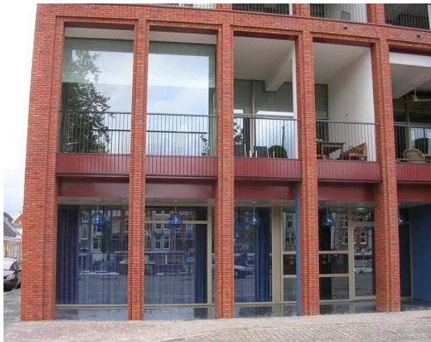
Referentiebeelden bebouwing langs de Kanaalweg
